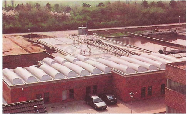
Klärwerk Bergisch-Gladbach mit verschiedenen Abdeckungen
