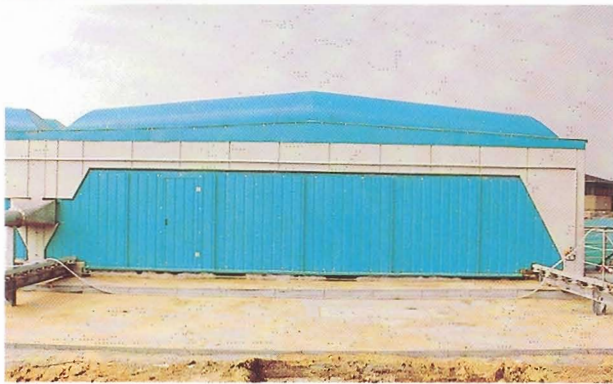
Demontables Eingangstor mit eingebauter GFK-Schlupftür
