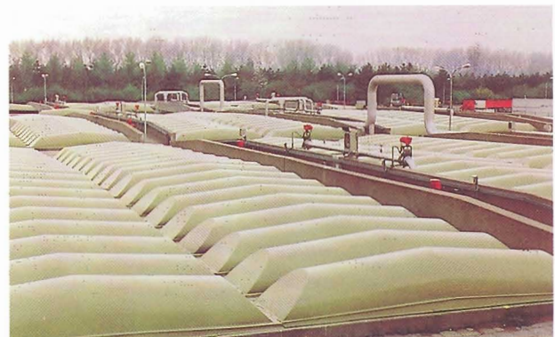
Abdeckung auf sanierte Beton-Becken mit GFK-Auflagen an den Brücken
