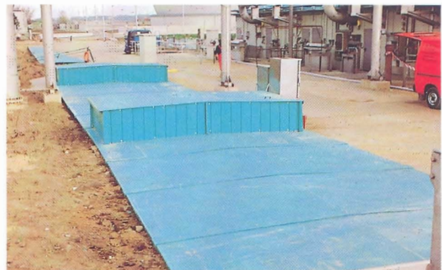
Begehbare Rinnenabdeckung mit rutschsicherer Oberfläche, Sticherhöhung und Einhausung für Maschinenaufsätze
