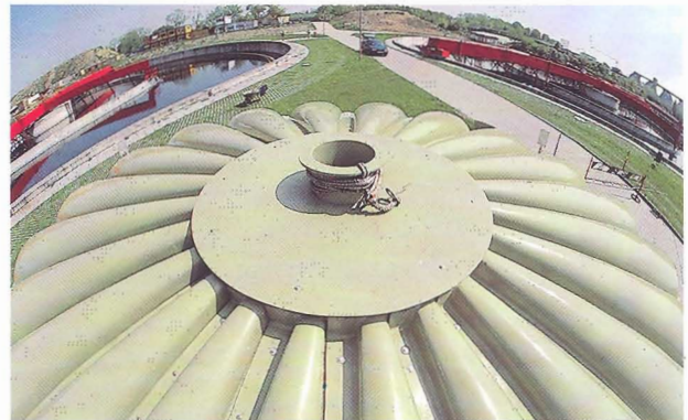
Rundbehälter freitragend, mit GFK-Spannring, Abdeckplatte und Lüftungsstützen. Spannweiten bis ca. 50,00 m
