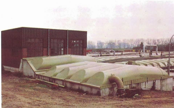
Zwischenpumpwerk: Abdeckung quer zur Fließrichtung
