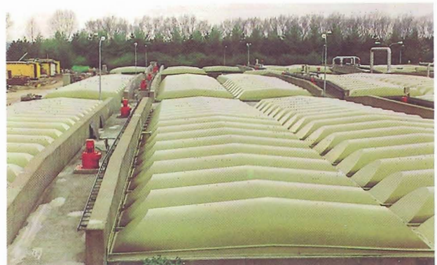
Schwachlastbelebungs ca. 7 500 m 2 Fläche, Spannweiten bis 7,50 m
