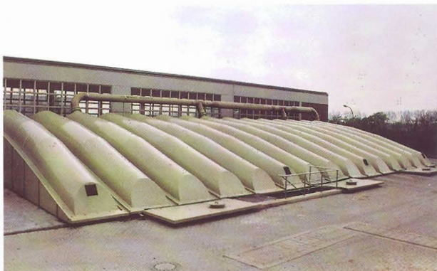
Schneckenpumpwerk – Spannweiten bis 13,80 m
